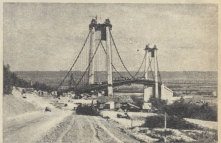
Le pont de Tancarville en cours de construction.
